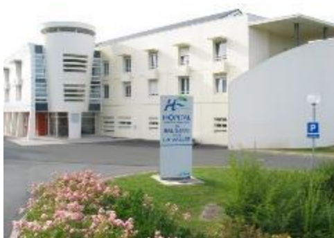
Site de BAUGE
